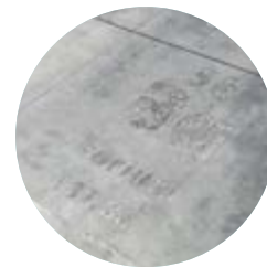
Béton gravé avec joints d'expansion en motifs
