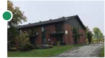
1401, rue du Centenaire Saint-Télesphore Immeuble pour aînés autonomes (10 logements)
