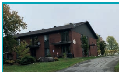
1401, rue du Centenaire Immeuble pour aînés autonomes (10 logements)
