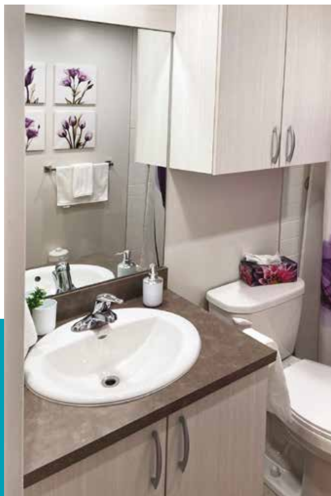
Travaux de réfection réalisés en 2021, salle de bain au 155, 37 e avenue à Saint-Zotique
