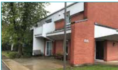
106, chemin Duhamel Immeuble pour aînés autonomes (15 logements)
