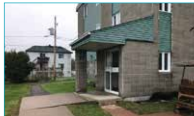
95, Place des Outaouais Immeuble pour les familles (12 Logements)
