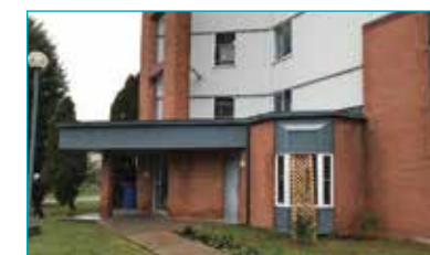
2600, rue du Manoir Immeuble pour les familles (12 Logements)
