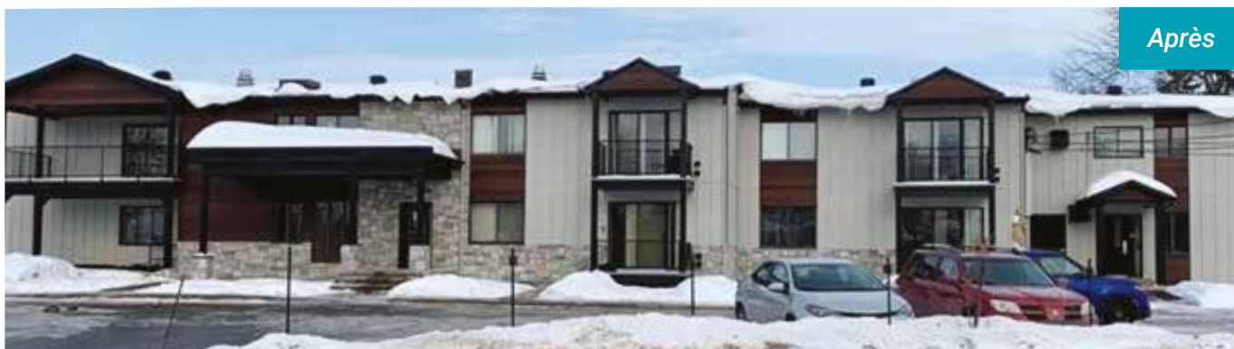
Travaux majeurs réalisés en 2021 au 1250, chemin de l'Église à Saint-Polycarpe.
