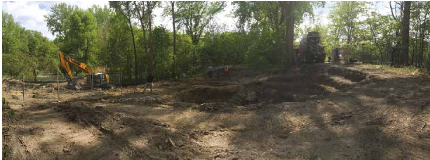
Travaux de remplacement d'une partie affaissée de la conduite d'eau dans la digue du canal de Soulanges.
